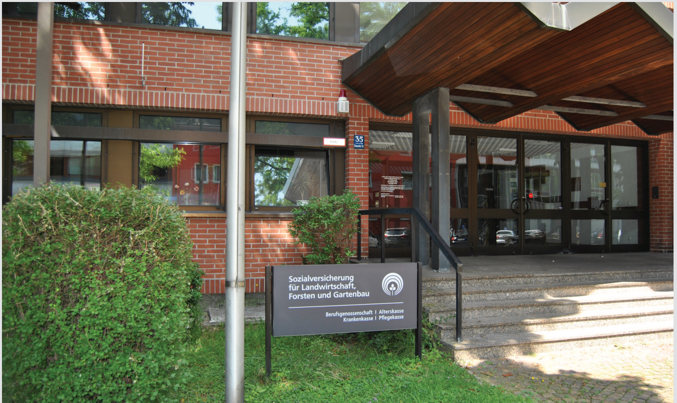
Haupteingang des Gebäudes an der Neumarkter Straße
