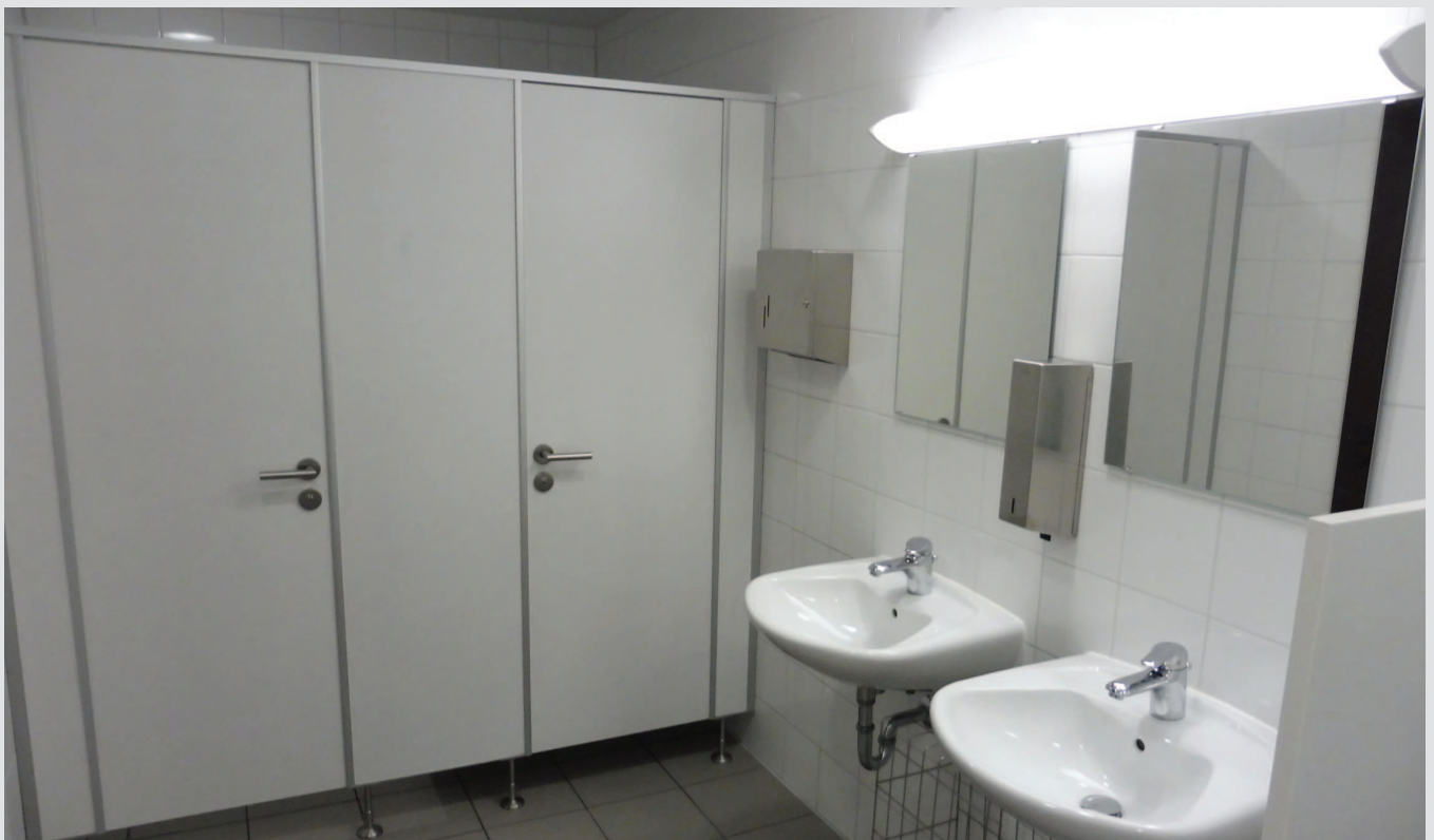
Toilettenanlage im 2. Obergeschoss
