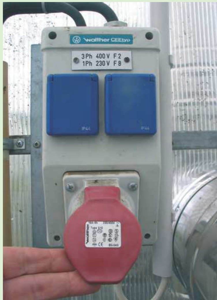
Spritzwassergeschützte Steckdosen
