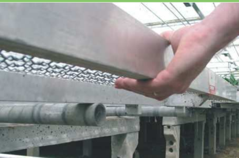
Ausreichender Sicherheitsabstand an der Tischunterkante mindestens 130 mm
