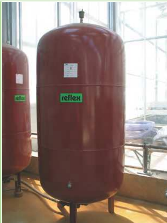
Wassermangel- sicherung (rechts)
