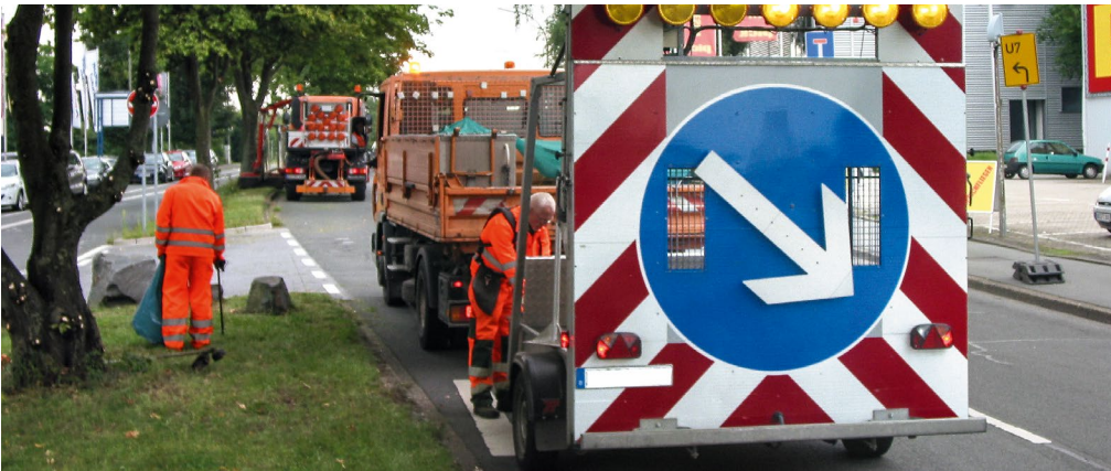
Grünpflege-Kolonne an der Straße mit Nachläufer zur Baustellenabsicherung
