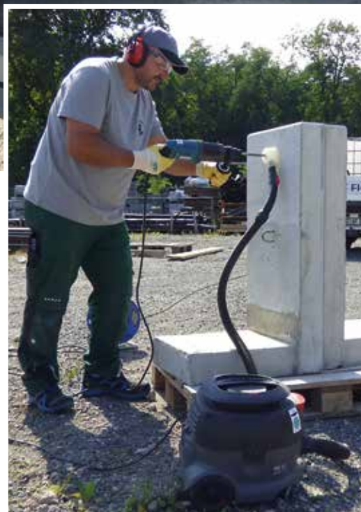
Absaugung direkt an der Bohrstelle
