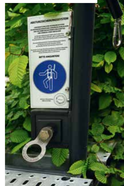
Gut gekennzeichnete, geprüfter Anschlagpunkt
