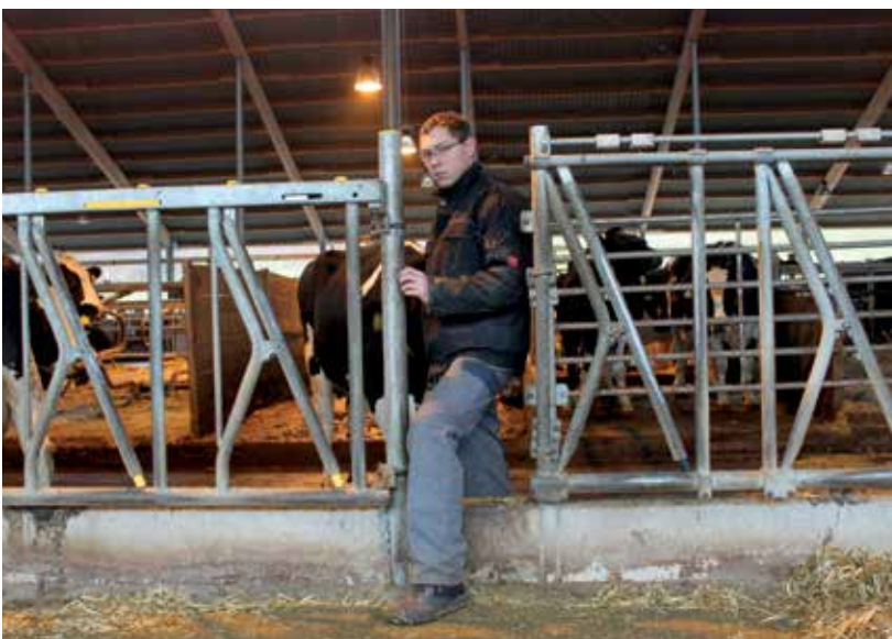
Eine Personenschlupföffnung ermöglicht das gefahrlose Betreten und Verlassen des Laufstalles
