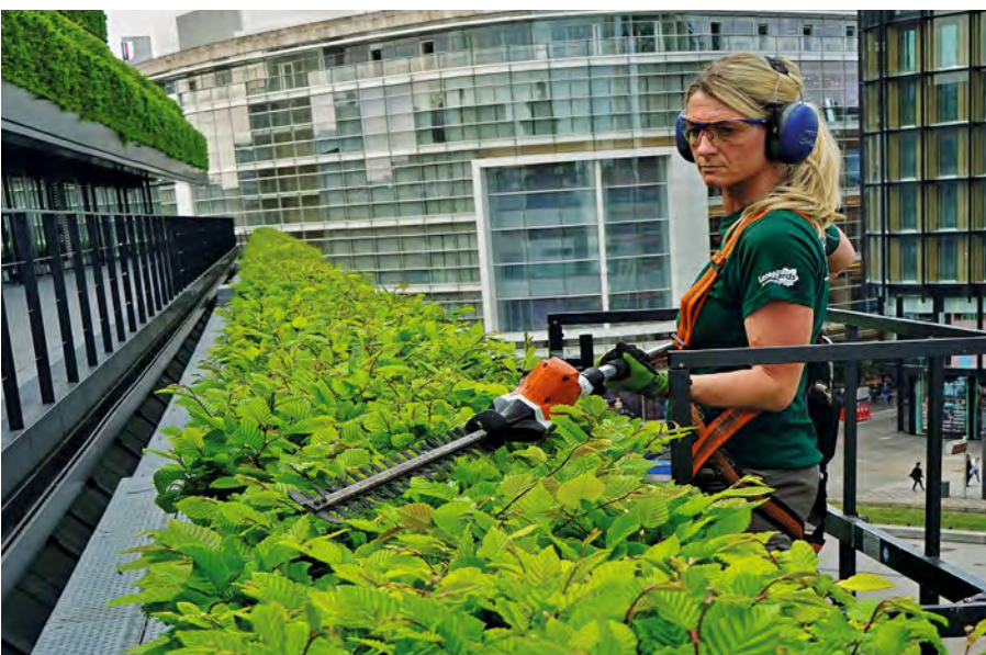
Sicher und geschützt wird die begrünte Fassade des Düsseldorfer Kö-Bogens II geschnitten.
