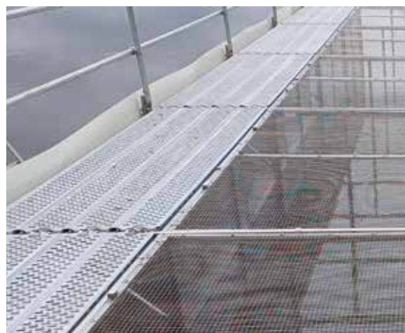
Sicherer Laufsteg in einer Hälteranlage am Teich
