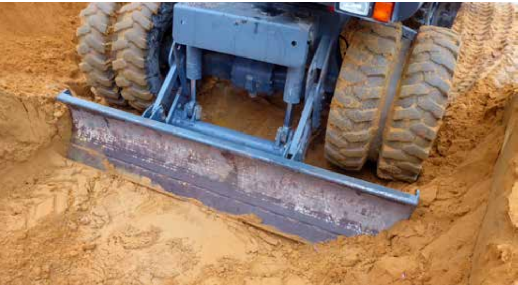
Hydraulikbagger sind in der Regel mit einem Planierschild ausgerüstet. Dieses ist vor Beginn der Baggerarbeiten abzusenken und führt so zu einer Verbesserung der Standsicherheit.
