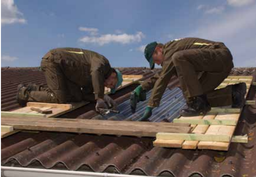
Auf Laufbohlen lassen sich Dacharbeiten sicher durchführen.
