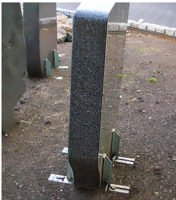
Klemmstandsicherung als Standsicherungsmaßnahme
