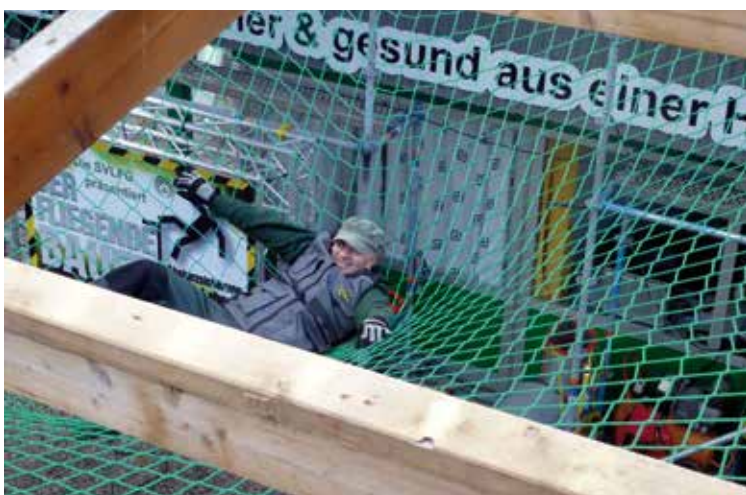
Auf der NORLA wurde demonstriert, wie notwendig eine gute Absturzsicherung auf Baustellen tatsächlich ist. Ein Arbeiter/Stuntman stürzte spektakulär durch die Decke eines halbfertigen Hauses. Während ein erster Sturz ohne Sicherung in einen Haufen Pappkartons erfolgte, fiel der Arbeiter beim zweiten Mal in ein Auffangnetz.
