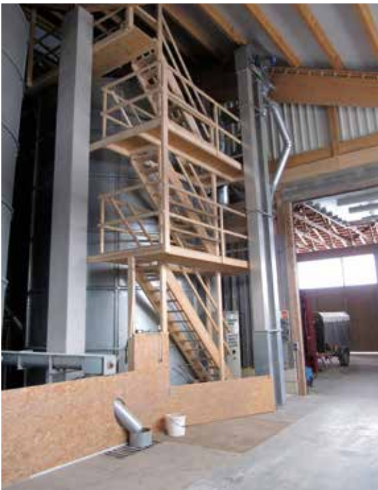
Nach Beratung durch den Außendienst baute der Unternehmer eine Treppe zum Siloaufstieg ein.
