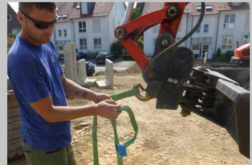
Körperliche Anstrengungen vermeiden: Der Einsatz geeigneter Anschlagmittel an zugelassenen Anschlagpunkten entlastet die Mitarbeiter.
