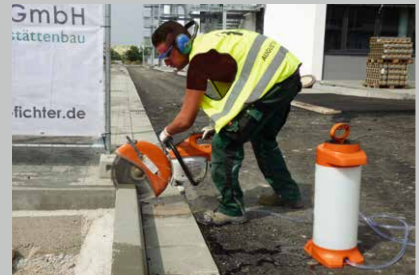
Staubfreies Arbeiten: Moderne Trennschleifer und Schneidetische verfügen über Wasseranschluss oder Absaugung.
