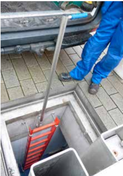
Geöffneter Schachteinstieg in abgesperrtem Bereich
