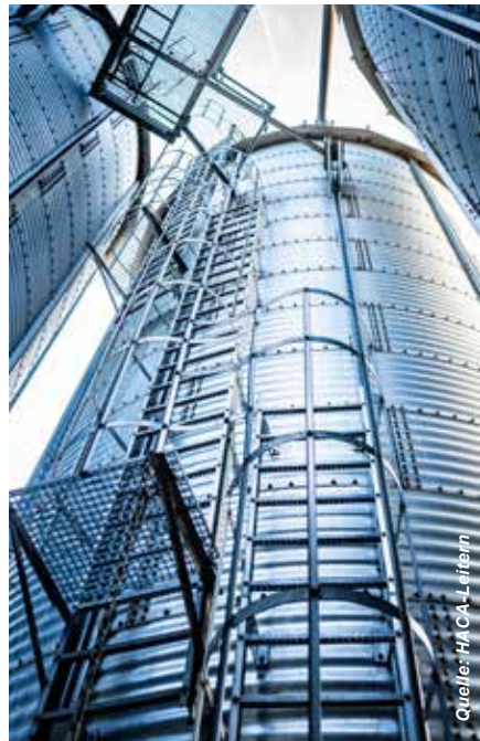
Steigleiter mit Ruhepodest
