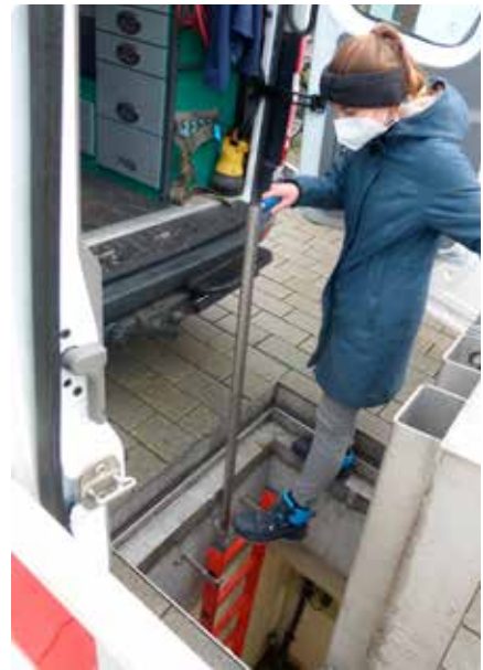
Sicherer Einstieg durch Handgriff und sichtbare Sprosse
