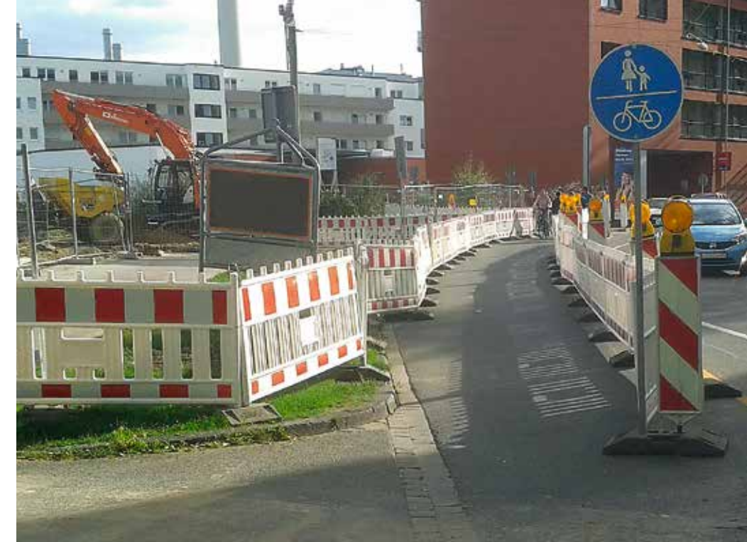
Gute Baustellensicherung mit Baken, Absperrschranken, Beleuchtung und Geh- beziehungsweise Radwegalternative.
